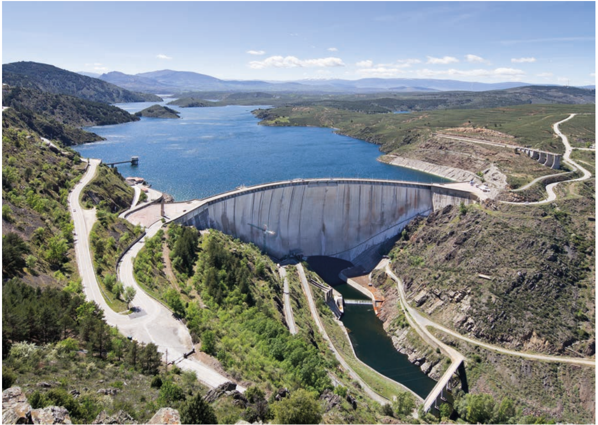
Barrage de El Atazar, Communauté de Madrid, Espagne, 2014. La voûte mesure 134 m de haut.
